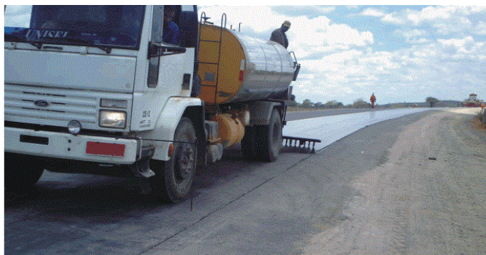
Figura 04 - Execução da pintura de ligação
