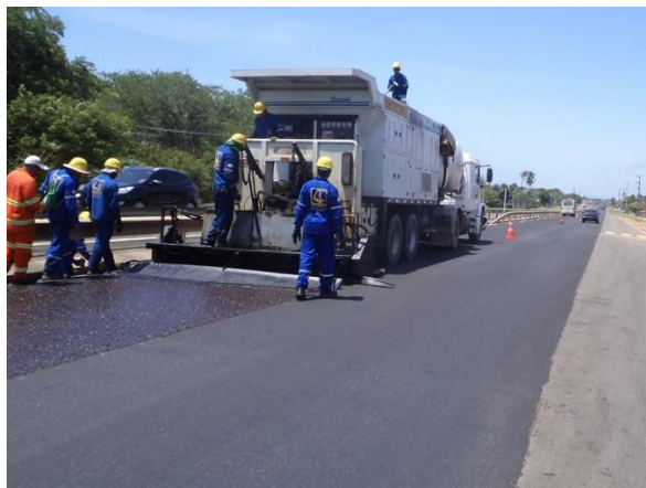
Figura 06 - Execução de micro-revestimento asfáltico a frio (2)
