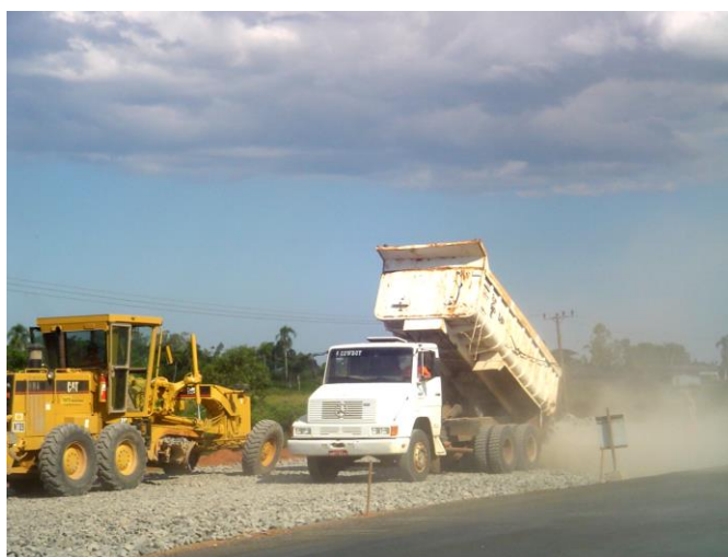
Figura 03 - Execução da camada de enchimento
