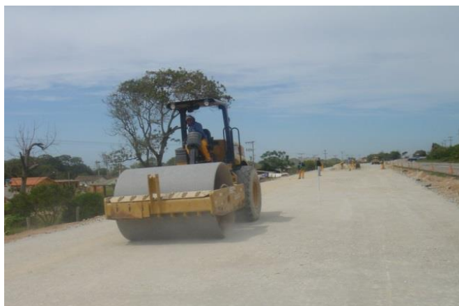
Figura 03 - Execução da camada de enchimento
