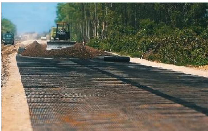
Figura 08 - Geogrelha bidirecional aplicada no pavimento
