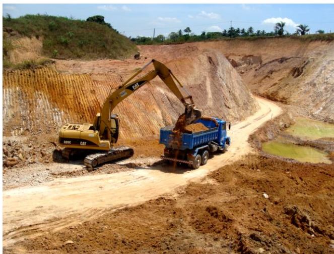
Figura 09 - Escavação e carga de material de jazida com escavadeira hidráulica
