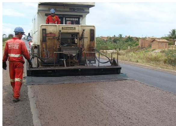
Figura 06 - Execução de micro-revestimento asfáltico a frio (2)
